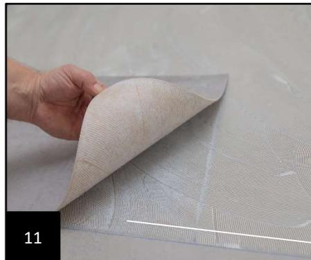
Markieren sie nun das einzusetzende Element (12) und schneiden dieses passgenau so zu, dass die Randfugen (13) offenbleiben, um Schallbrücken und Stauchungen an Wänden und Türzargen zu vermeiden.
